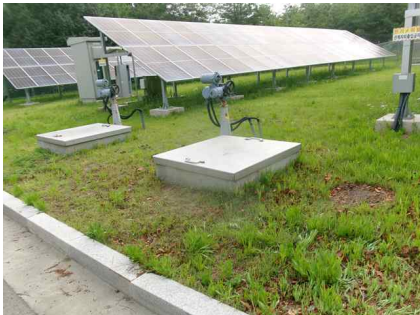
<통합유출밸브실 지하1층 전경>
