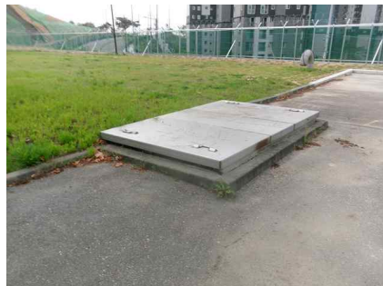
<환기구 등의 덮개(장비 반입구) 현황>
