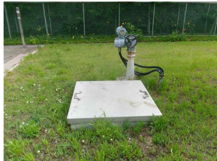
<유입밸브실 지하2층 전경>
