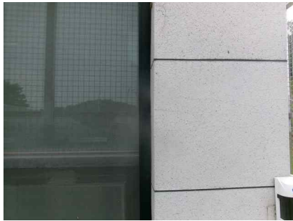
<검수실 외부 벽체 균열>
