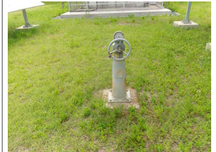
<배수지 상부 전경>
