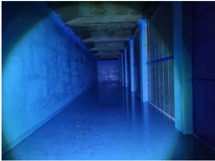
<배수지 1지 전경>
