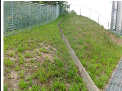
<배수로U 형 전경>
