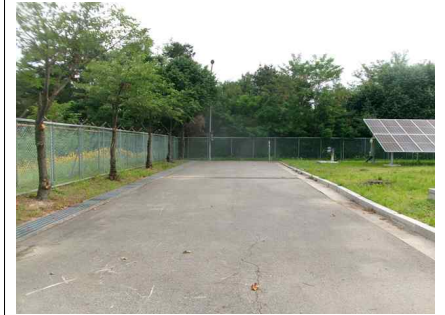
<진입로 포장 전경>
